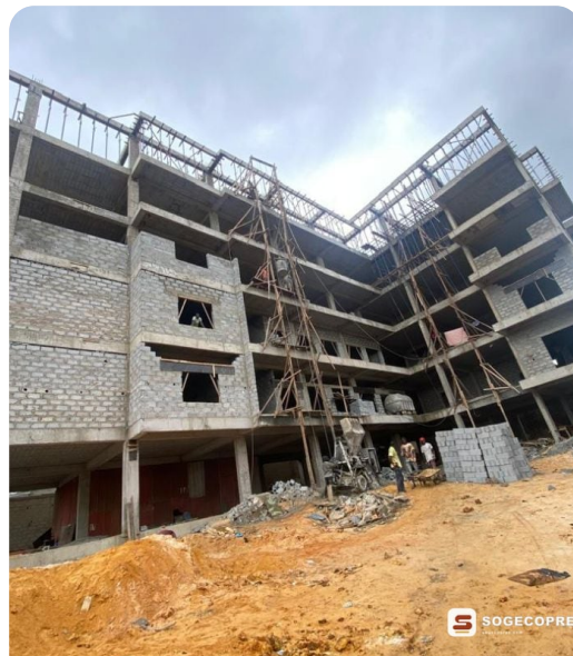
Immeuble privé à Kipé — chantier SOGECOPRES
